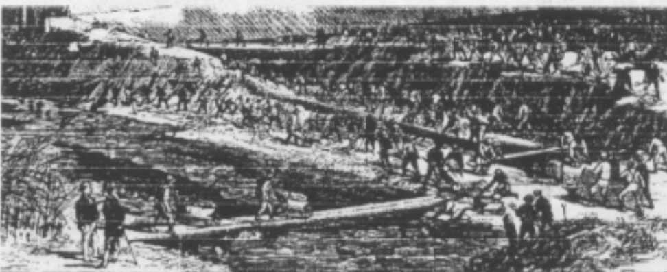
Les responsables de la Commission terrain (s.g.) sur le chantier
